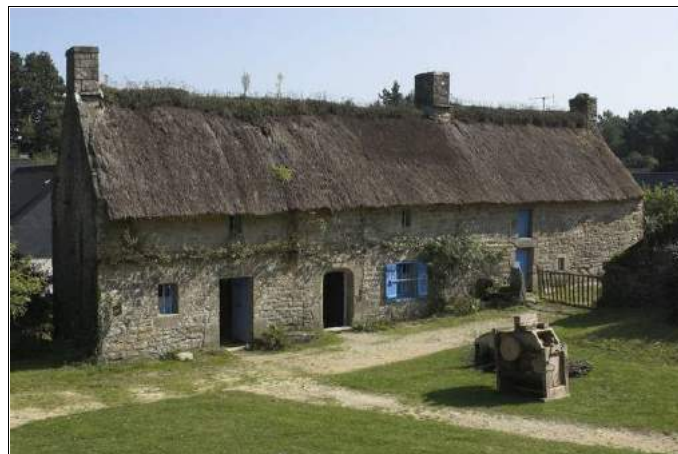
Le parti pris de la restauration utilisant les matériaux et les
